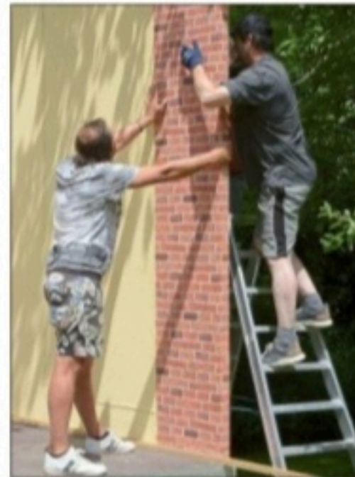
Der Bühnenaufbau wird montiert.
